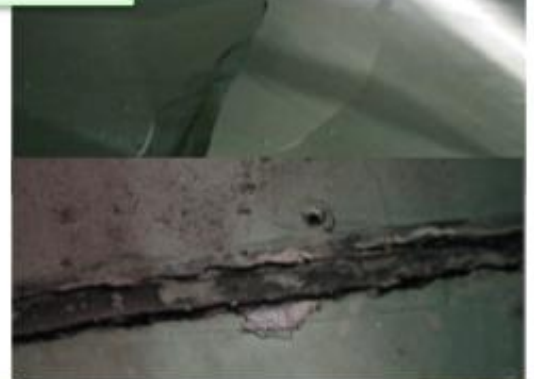
OL028、OR112 Exp.Joint 隙間。大穂側が上がっている。
